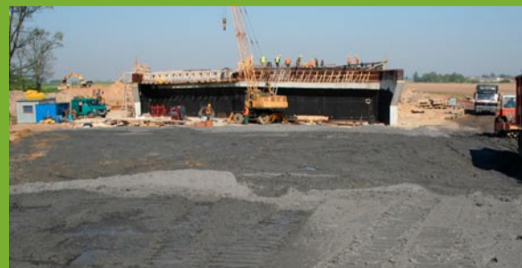
Budowa nasypów obwodnicy Oleśnicy
