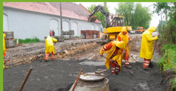
Przebudowa dróg – Piecowice, gmina Długołęka
