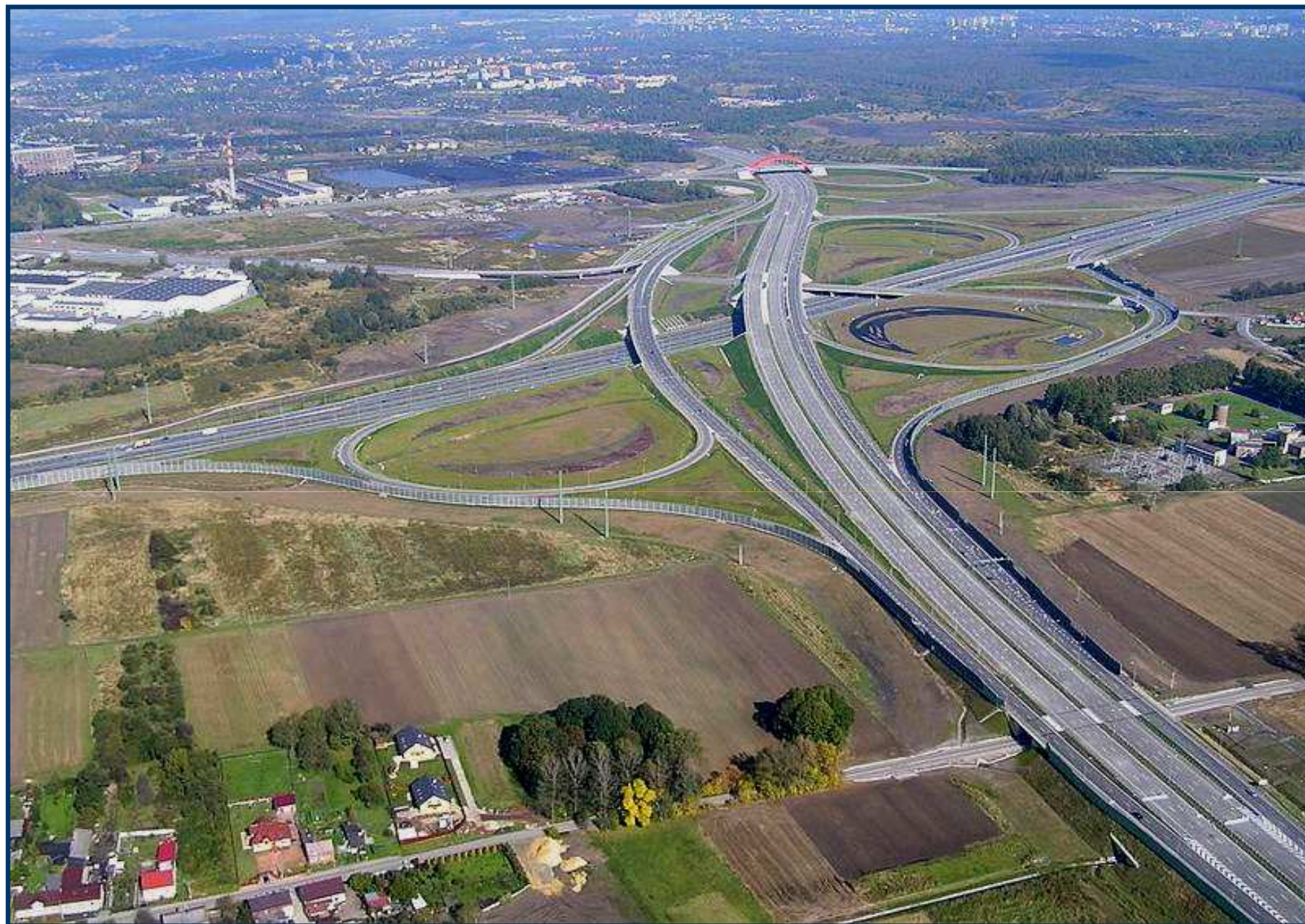
BUDOWA WĘZŁA A1-A4 SOŚNICA
